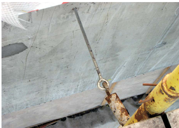
Монтаж строительных лесов
