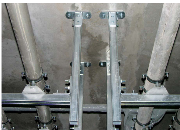
Монтаж инженерных систем
