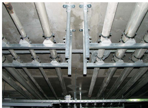
Монтаж инженерных систем
