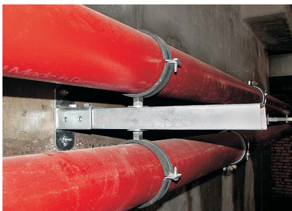
Монтаж инженерных систем
