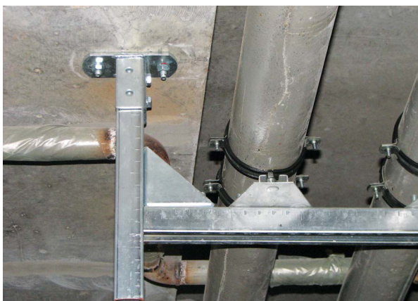
Монтаж инженерных систем
