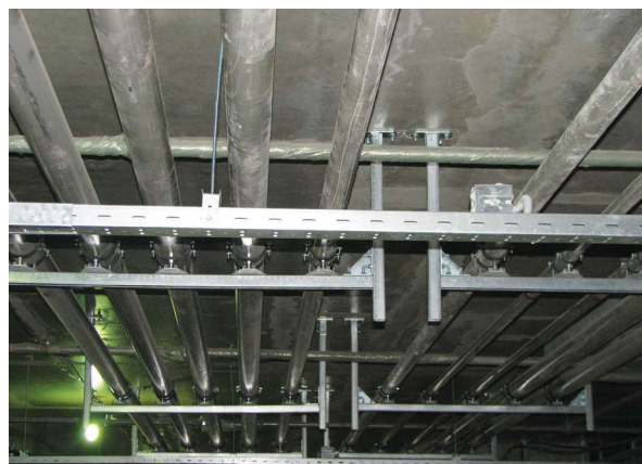
Монтаж инженерных систем
