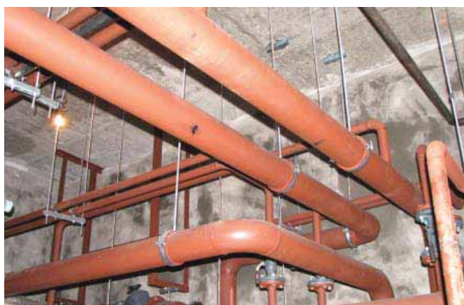
МОНТАЖ ИНЖЕНЕРНЫХ КОММУНИКАЦИЙ СТАЛЬНЫМИ РАСПОРНЫМИ АНКЕРАМИ
