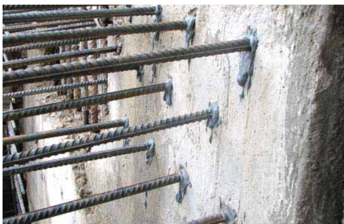
ПРИМЕНЕНИЕ ХИМИЧЕСКИХ КЛЕЕВЫХ АНКЕРОВ ПРИ ФОРМИРОВАНИИ АРМАТУРНЫХ ВЫПУСКОВ
