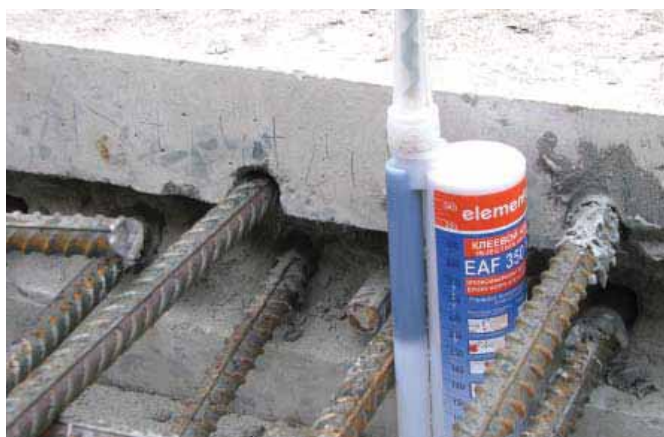
ПРИМЕНЕНИЕ ХИМИЧЕСКИХ КЛЕЕВЫХ АНКЕРОВ ПРИ ФОРМИРОВАНИИ АРМАТУРНЫХ ВЫПУСКОВ
