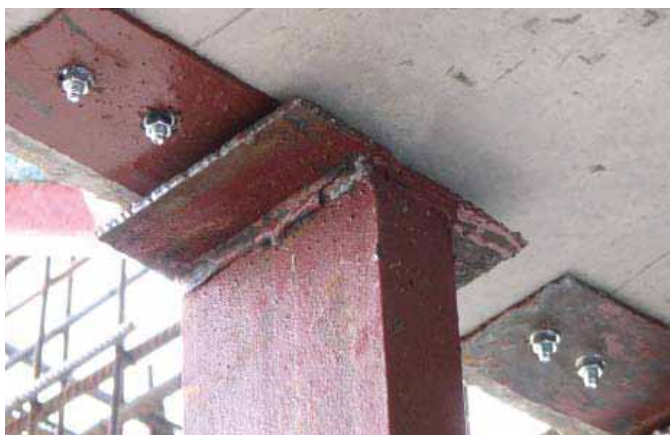
МОНТАЖ ИНЖЕНЕРНЫХ КОММУНИКАЦИЙ СТАЛЬНЫМИ РАСПОРНЫМИ АНКЕРАМИ
