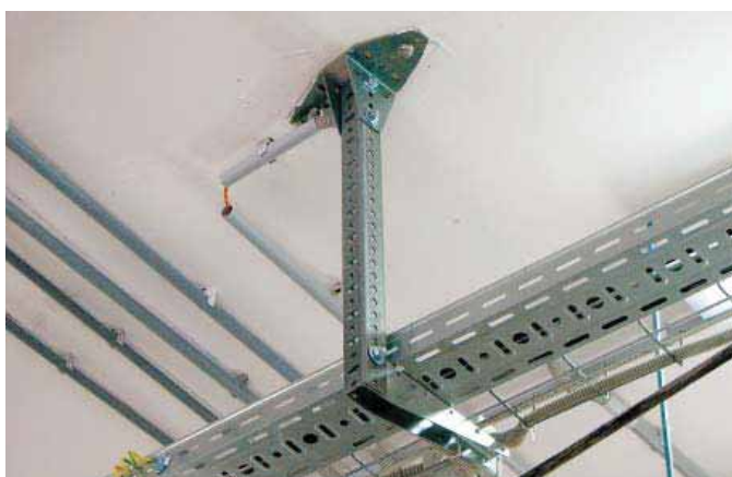
МОНТАЖ ИНЖЕНЕРНЫХ КОММУНИКАЦИЙ СТАЛЬНЫМИ РАСПОРНЫМИ АНКЕРАМИ
