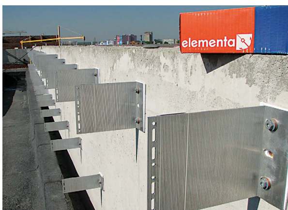
Монтаж кронштейнов НФС
