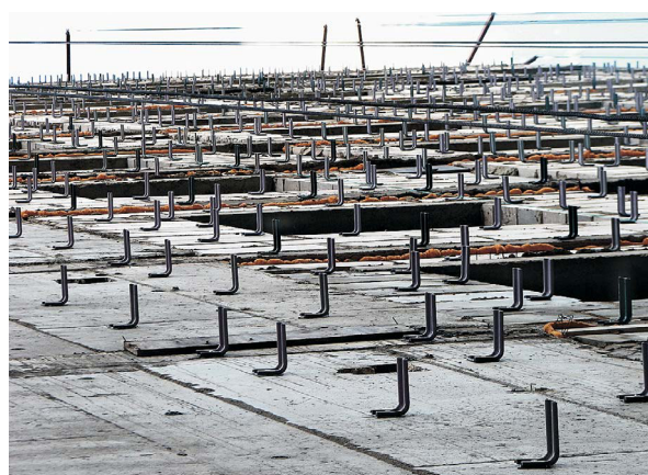
Монтаж кронштейнов НФС
